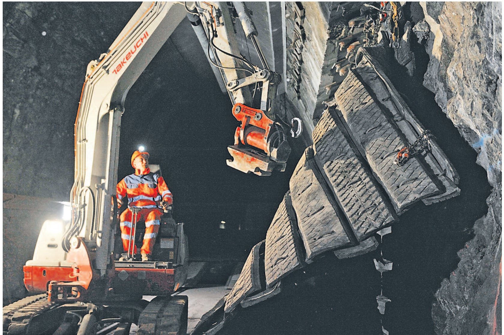
Wenig Platz. Die Kabelverbindungen der Stromversorgung müssen im Fels eingelassen werden, was jeweils eine Sprengung erforderlich macht.
